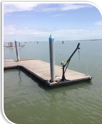
Pontile galleggiante per l'imbarco e lo sbarco, accessibile a tutti e dotato di gruetta con imbrago per l'atleta.
