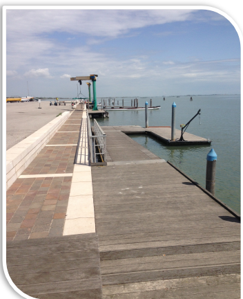
Pontile galleggiante per l'imbarco e lo sbarco, accessibile a tutti e dotato di gruetta con imbrago per l'atleta.
